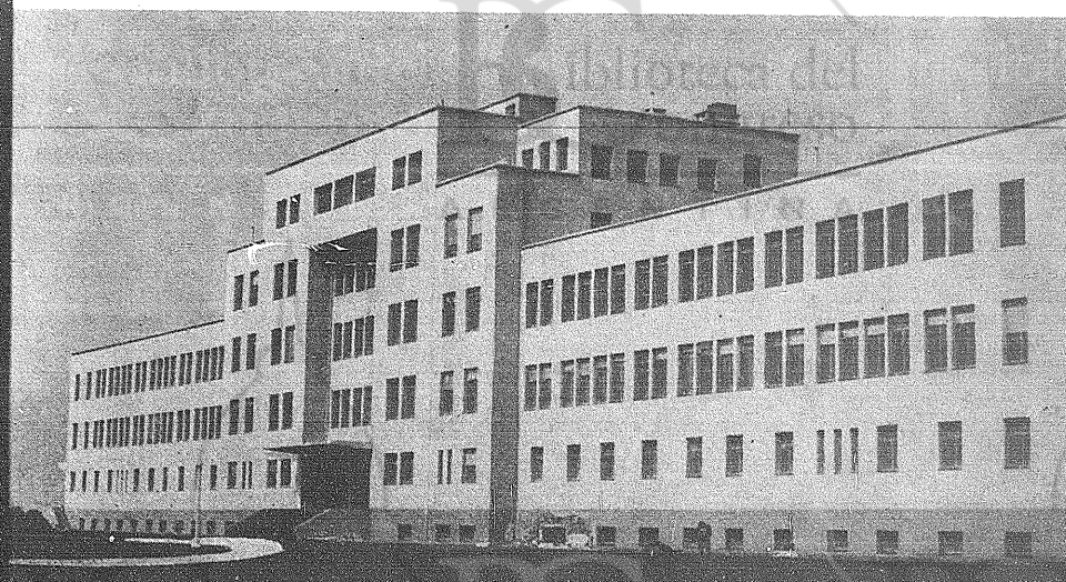
Das aufbauende Gewerkschaftsleben in Argentinien zeichnet sich durch seine sozialen Werke aus. Diese Poliklinik ist ein Werk der Gewerkschaft der Glasarbeiter.
