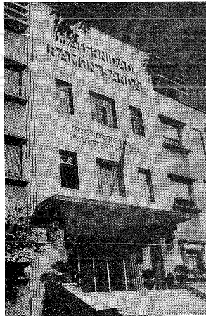
Le maternità della nuova Argentina dispongono di tutti gli ultimi ritrovati della scienza in questo campo.
