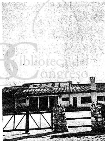
Edificio de la planta transmisora en pajas blancas
