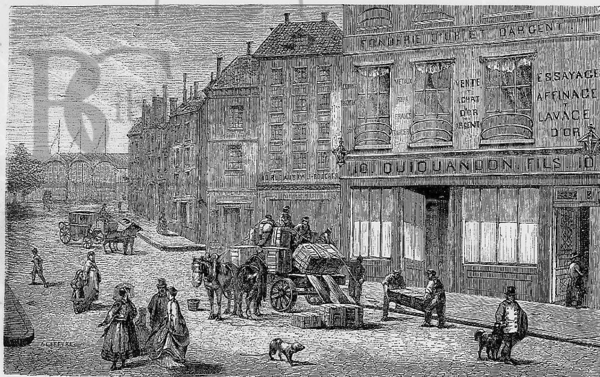
Fundición de oro y plata de la casa QUIQUANDON hijo, 10, rue Aubry-le-Boucher, en París. Vista exterior del establecimiento.
